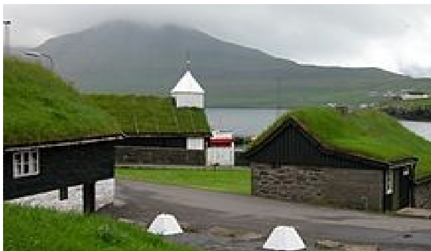
Рис. 2. Традиционные дерновые крыши на Фарерских островах
