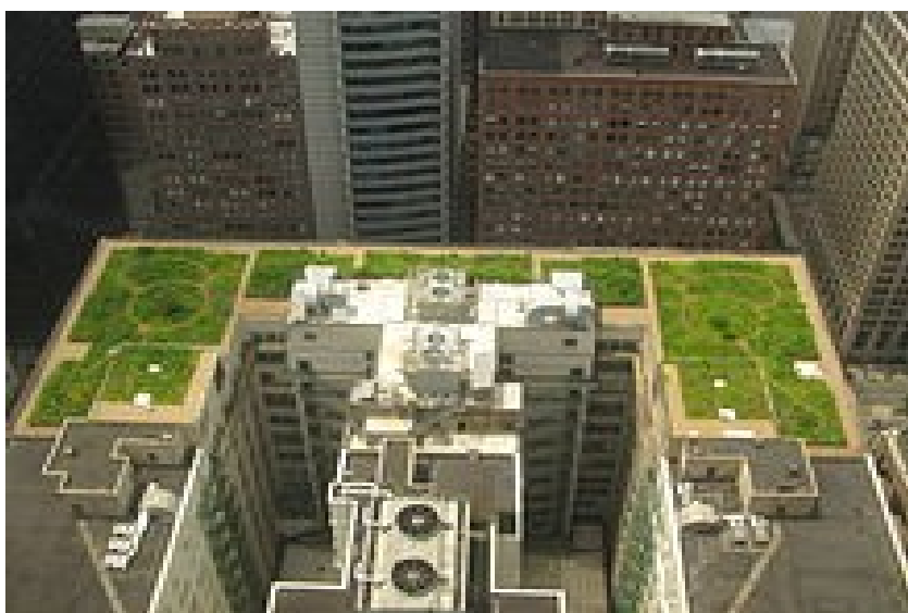
Рис. 3. «Зеленая крыша» здания муниципалитета в Чикаго, Иллинойс
