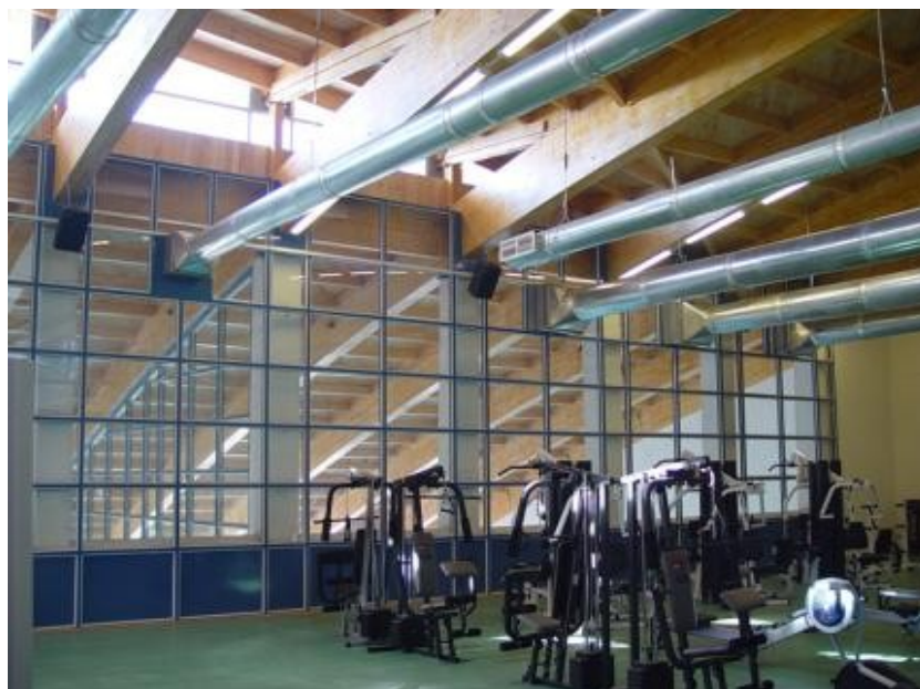
Иллюстрация 2. Тренажерный зал школы с видом на бассейн, освещение – через «фонарь верхнего света» в крыше.
